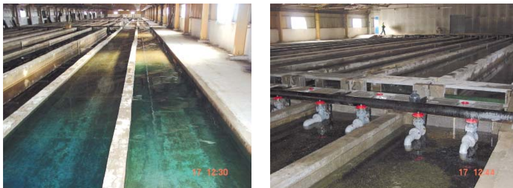
Рис. 63. Прямоточные бассейны дальневосточного типа, Рязановский ЛРЗ, Приморский край: слева – общий вид; справа – система водоснабжения бассейнов
