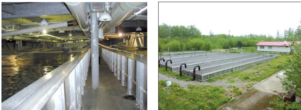
Рис. 65. Прямоточные металлические бассейны, Янский ЛРЗ, Магаданская область: слева – крытые, справа – открытые
