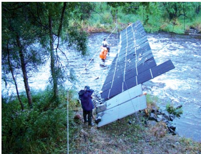
Рис. 1. Установка рыбоучетного заграждения на р. Кулькаты
