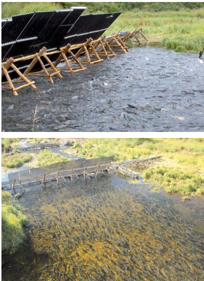
Рис. 2. Рыбоучетное заграждение, изготовленное из пластиковых щитов и установленное в русловом садке
