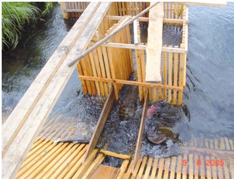
Рис. 3. Деревянное рыбоучетное заграждение и ловушка для накопления рыбы, установленная в РУЗе на малом водоеме
